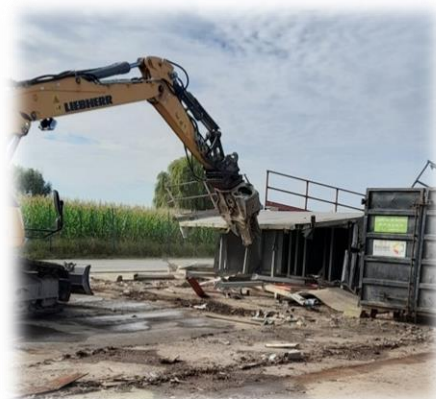
Démantèlement du quai
