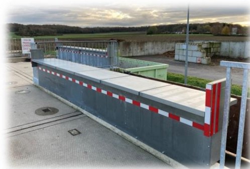
Déchèterie d'Eblinghem – Nouveau quai
